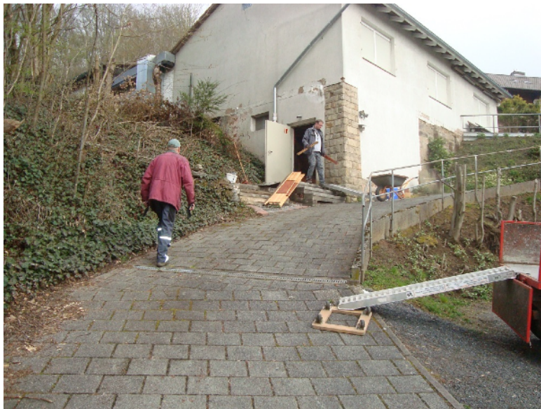
Foto 1: Beginn der Arbeiten
